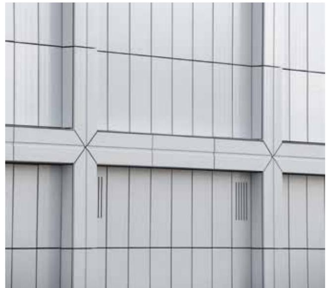
El revestimiento de los salientes, que le confieren a la fachada su estructura característica, requirió piezas de especial fabricación. Así pues, AGROB BUCHTAL no sólo desarrolló placas y secciones transversales especiales. El montaje también se basa en una solución individual detallada, en la combinación de la fijación K20 por garras y el perfil de sistema K20. Las placas en forma de flecha para los puntos de cruce fueron cortadas en fábrica a partir de patrones en diferentes diseños.
